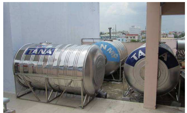
Hình 13: Thí điểm Mô hình thu gom nước mưa qui mô công trình
