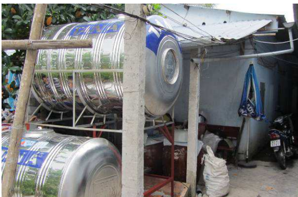
Hình 12: Thí điểm Mô hình thu gom nước mưa qui mô hộ gia đình
